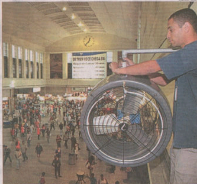
TECNICOS instalaram ontem, na Central, ventiladores e chuveirinhos para espalhar água pelo saguão principal
